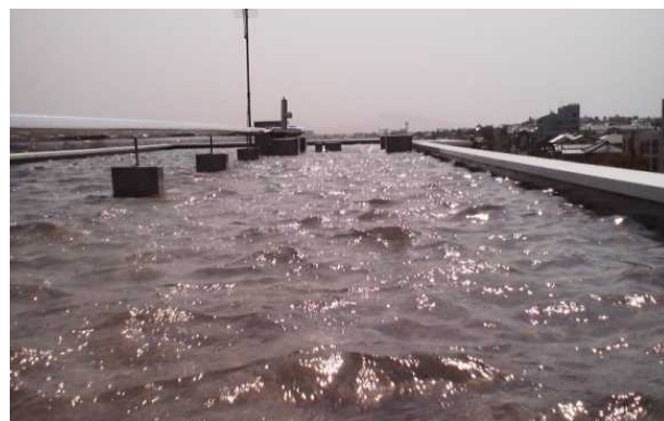
写真9 ルーフドレンの目詰まりによる屋上のプール化の状況
